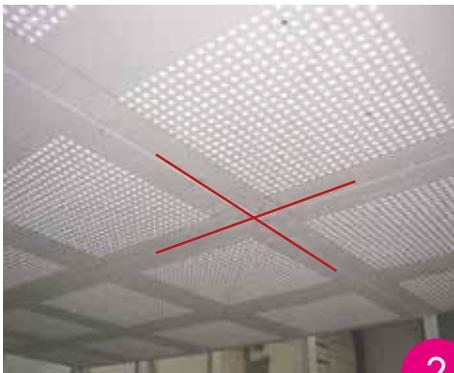
Las uniones de las placas **deben ir en cruz** (sin traslapar) para mantener la continuidad en la alineación de las perforaciones. (Fig.02).
