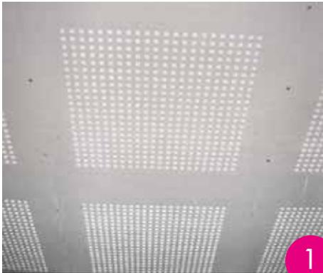
Las placas se **fijan perimetralmente y en el centro**, evitando dañar las perforaciones que traen las placas de fábrica, siguiendo el mismo criterio y distanciamiento de tornillos que las placas convencionales de yeso para cielos. (Fig.01).
