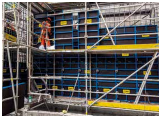
Encofrado rápido de muros gracias a un manejo sencillo
